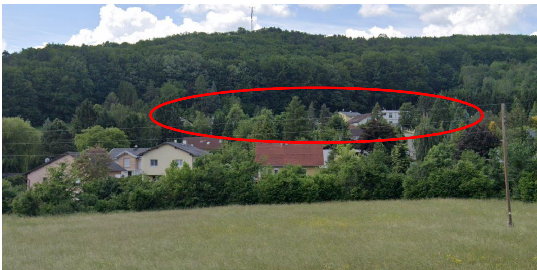
Abbildung 37: Blick von der L128 Hauptstraße auf den Siedlungsbereich Brunnfeldgasse (vordere Gebäude) / Lärbaumweg (exponiert liegende Gebäude im Hintergrund, siehe rote Umrandung) - im Vordergrund verläuft der Mödlingbach. Quelle: Google Street View, Aufnahme von Juni 2021, Stand: 31.01.2023
