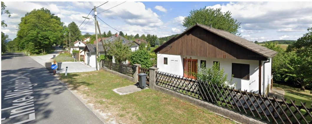
Abbildung 19: Bebauungsstruktur Linke Wöglerin, Bereich Abzweigung Waldweg. Quelle: Google Street View, Aufnahme von Juli 2019, Stand: 20.03.2023
