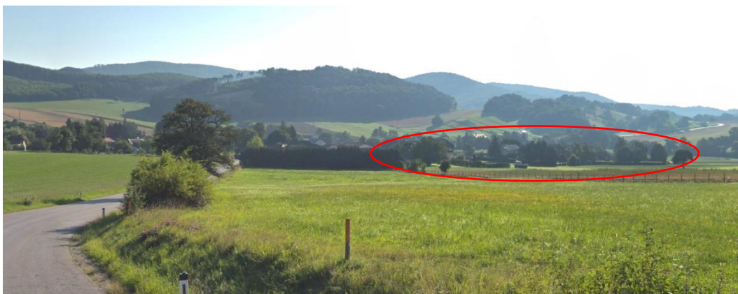
Abbildung 23: Blick auf Dornbach von Grub kommend (L2101), Kapellenweg siehe rote Umrandung. Quelle: Google Street View, Aufnahme von Juli 2018, Stand: 20.03.2023
