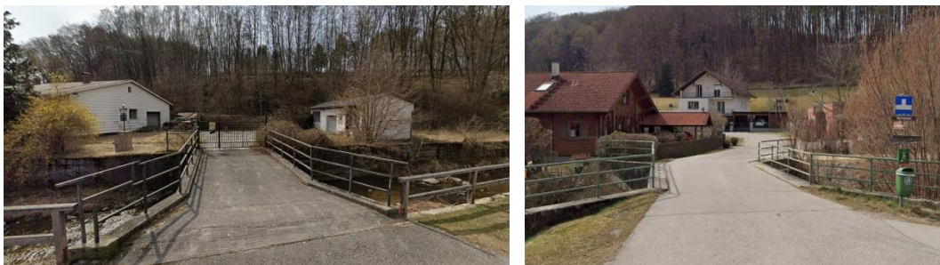
Abbildung 60 (links): Zufahrt zur Baulandfläche westlich der Bachgasse über eine Brücke. Quelle: Google Street View, Aufnahme von März 2022, Stand: 20.02.2022
