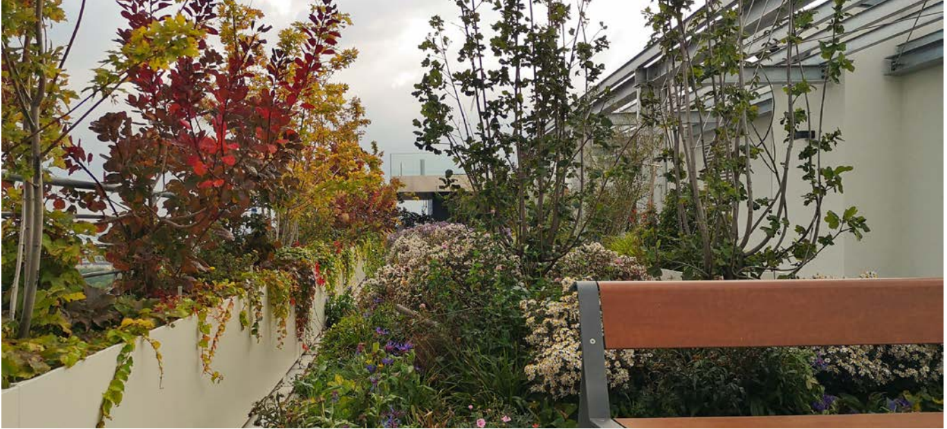
Üppige Dachbegrünungen bringen Abkühlungseffekte, speichern Regenwasser und schaffen zusätzliche Lebensräume und Erholungsflächen
