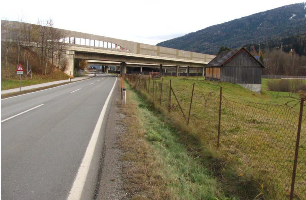
Abbildung 13: Lineare Infrastrukturprojekte (Brücke mit Lärmschutzwand): Zerschneidungseffekte, Schaffung von Sichtbarrieren
