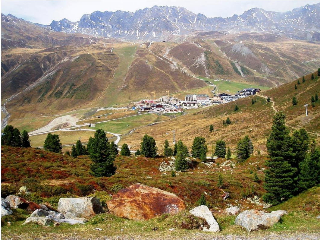
Abbildung 12: Siedlungsentwicklung: Flächeninanspruchnahme, Art von Bauweise und Kubatur im Bezug zur umliegenden Landschaft, Verlust des Landschaftscharakters Sichtbarkeit von Bauwerken
